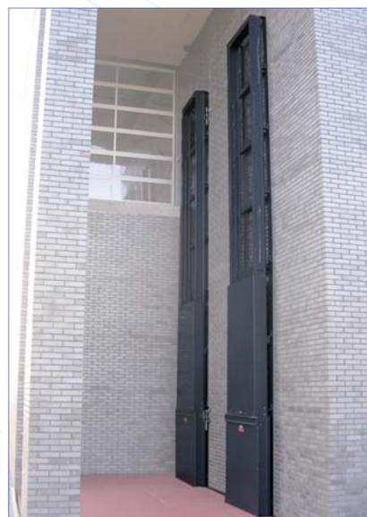
Figura 4. Elevador Montacargas guiado en doble columna EH/DCL.
